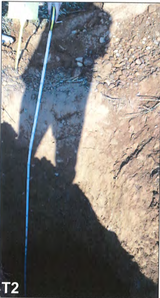
Foto 8 Trincea T2: particolare sezione scavo (profondità dal piano campagna = circa 3 m).
